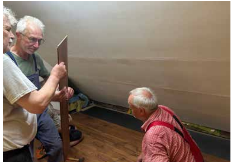
Umbauarbeiten im Dachboden des Dorfgemeinschaftshauses
